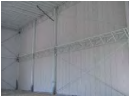
Fig. 22: Vista interior de panel en arreglo vertical.
