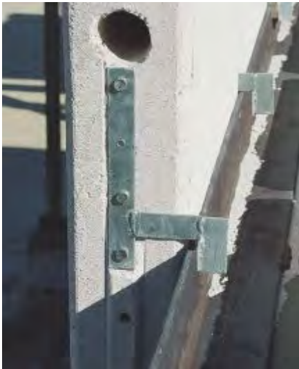
Fig. 20: Conector tipo "C" en extremo superior de panel.
