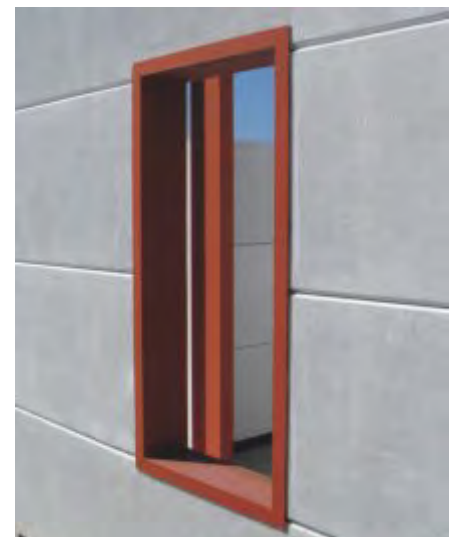
Fig. 29: Marco para vano de puertas o ventanas.
