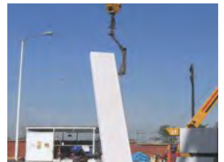
Fig. 16: Izar lentamente el panel hasta la posición de instalación.
